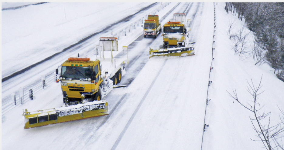
本線除雪作業
