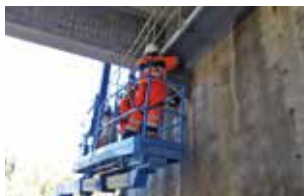
橋梁検査路補修
