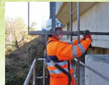
橋梁検査路補修 (6~11月)
