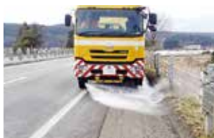
散水車による路面清掃
