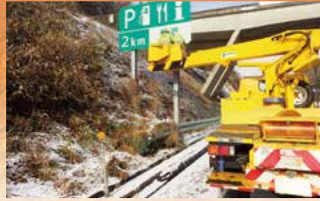
標識板取替 (7~11月) 劣化したり、表示サイン等が変更になった道路標識板を速やかに交換します。
