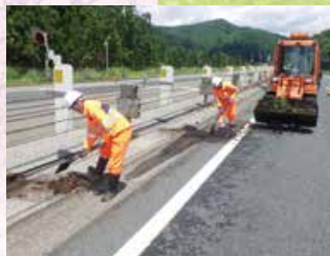
排水溝清掃 (4~11月)
