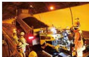
トンネル内舗装工事
