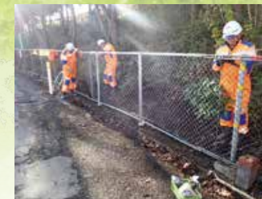
立入防止柵取替工 (8~12月)
