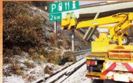
標識板取替 (7~11月)
