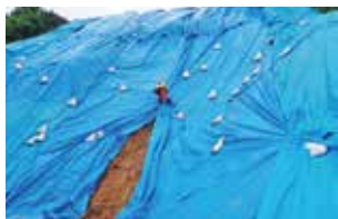
崩落のり面侵食防水シート張り工事
