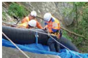
のり面縦排水溝補修工事
