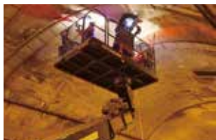
トンネル漏水桶設置工事
