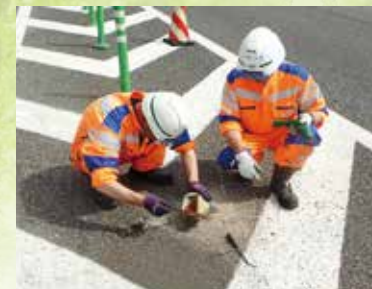
視線誘導標補修 (6~10月)
