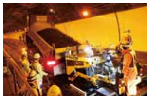
トンネル内舗装工事
